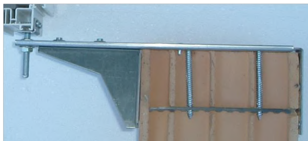
Przekrój – szyna wspomagająca + kątownik
